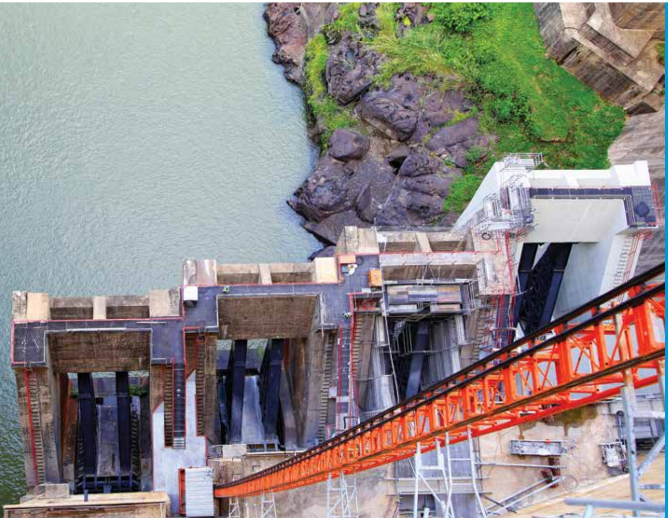
Vista parcial dos descarregadores
